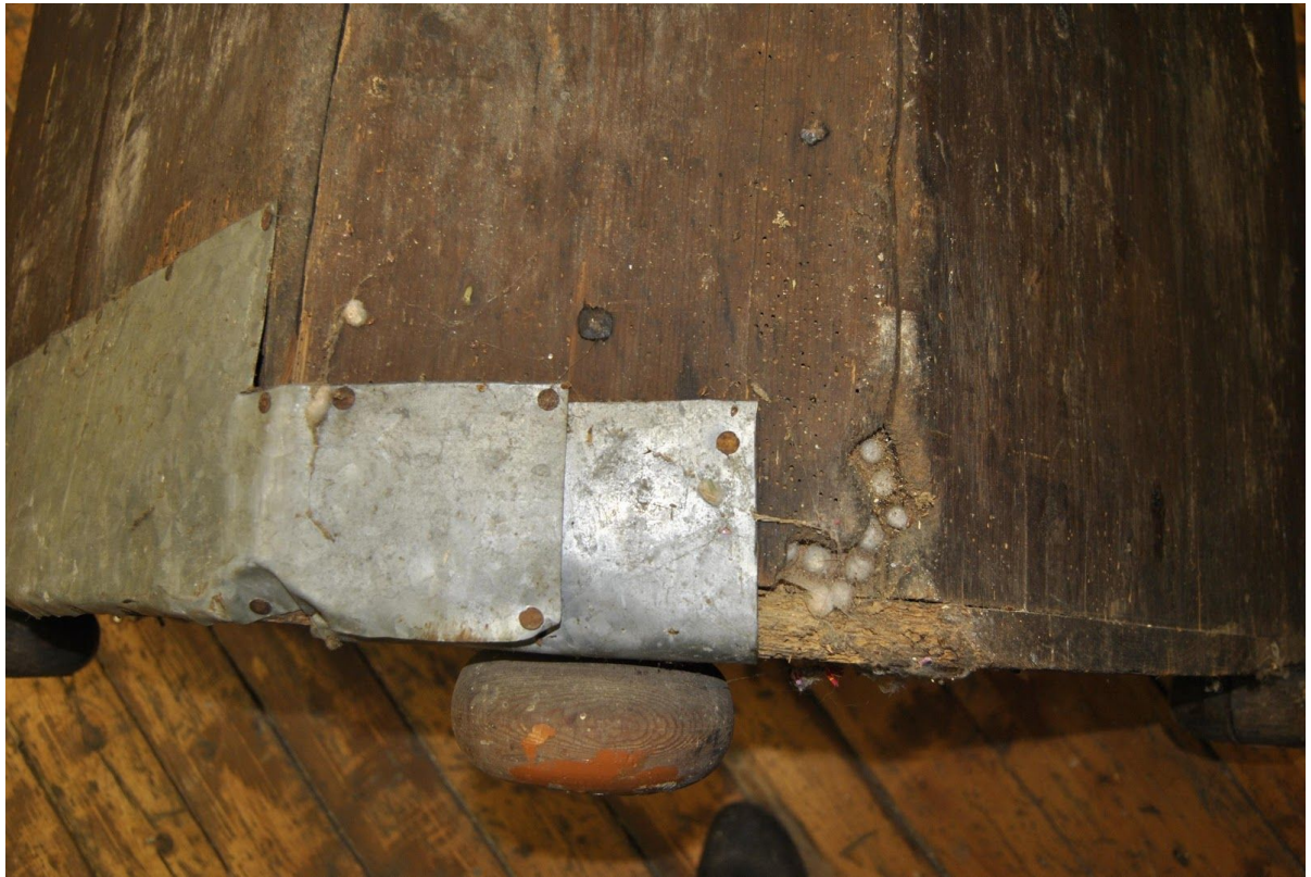
alumise kapi tagaseina nÄriliste kahjustuste hilisem parandus tsinkpleki ja naelte abil
