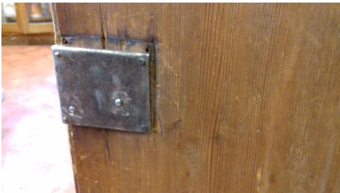
puudu olev uus valmistatud karplukk , valmistatud olemasoleva eeskujul
